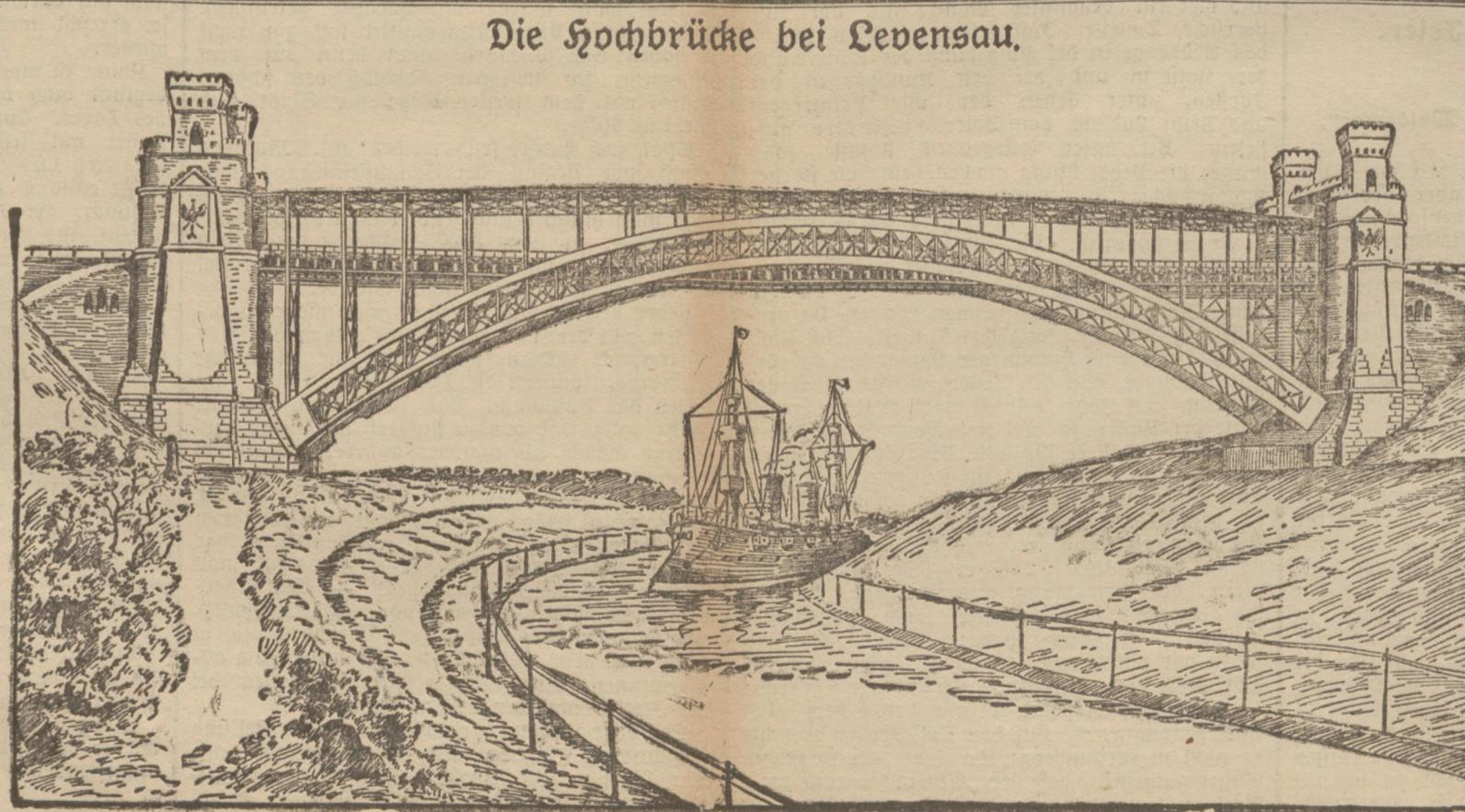
Die lichte Breite der Brücke beträgt 10½ Mr. wovon 8½ Meter dem Eisenbahn- und Wagenverkehr, 2 Meter dem Personenverkehr dienen. Architektonisch interessant sind vor allem die massiv gebauten Pfeiler. Aber mit dem Angenehmen und Schönen mußte man hier das Nützliche zu verbinden. Das Innere der Pfeiler ist für Vertheidigungszwecke eingerichtet; in den Mauern befinden sich Schießscharten und die unteren Gewölbe können je 400 Mann fassen.
