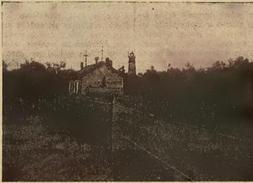
Latarnia morska na półwyspie helskim. Na przednim planie budynek, na którego dachu umieszczone są muszle potężnych syren, dających znaki w czasie mgły, gdy światło latarni jest s'abiej widoczne.
