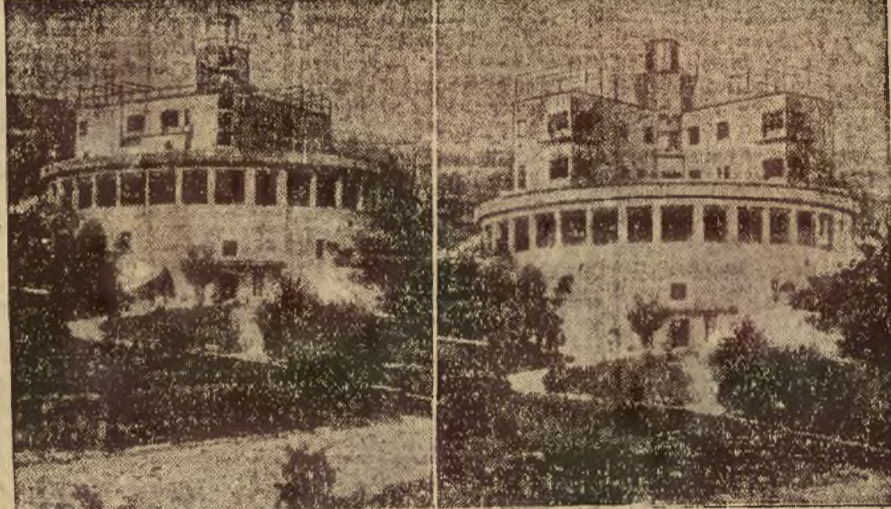
Dom — słończnik. Oryginalna konstrukcja willi, zbudowanej wedle pomysłu inż. włoskiego Invernizzi. Piętro tej willi obraca się dzięki sile małego motoru automatycznie ku stronie słonecznej.
