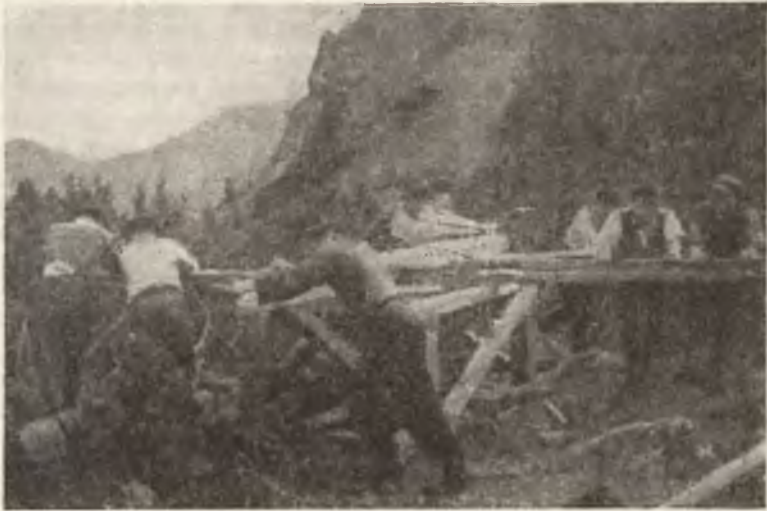
Napęd kieratowy kolejki roboczej w Dol. Różtoki podczas budowy schroniska w 5-ciu Stawach Polskich.
