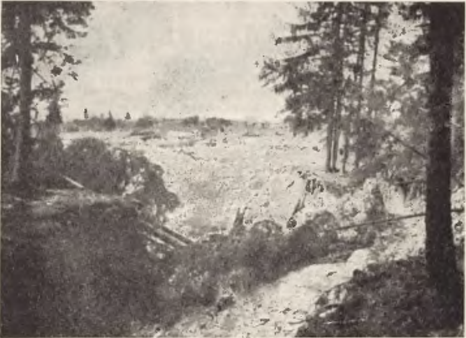
Osuwisko w Bańskiej Powalone drzewa na krawędzi cyrku osuwiskowego.
