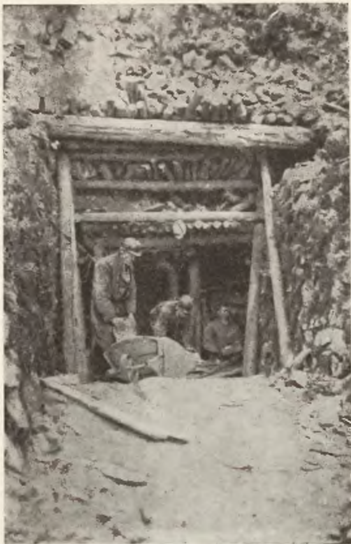
Belkowanie i mury oporowe przy północnym wylocie Jaskini Mroźnej.
