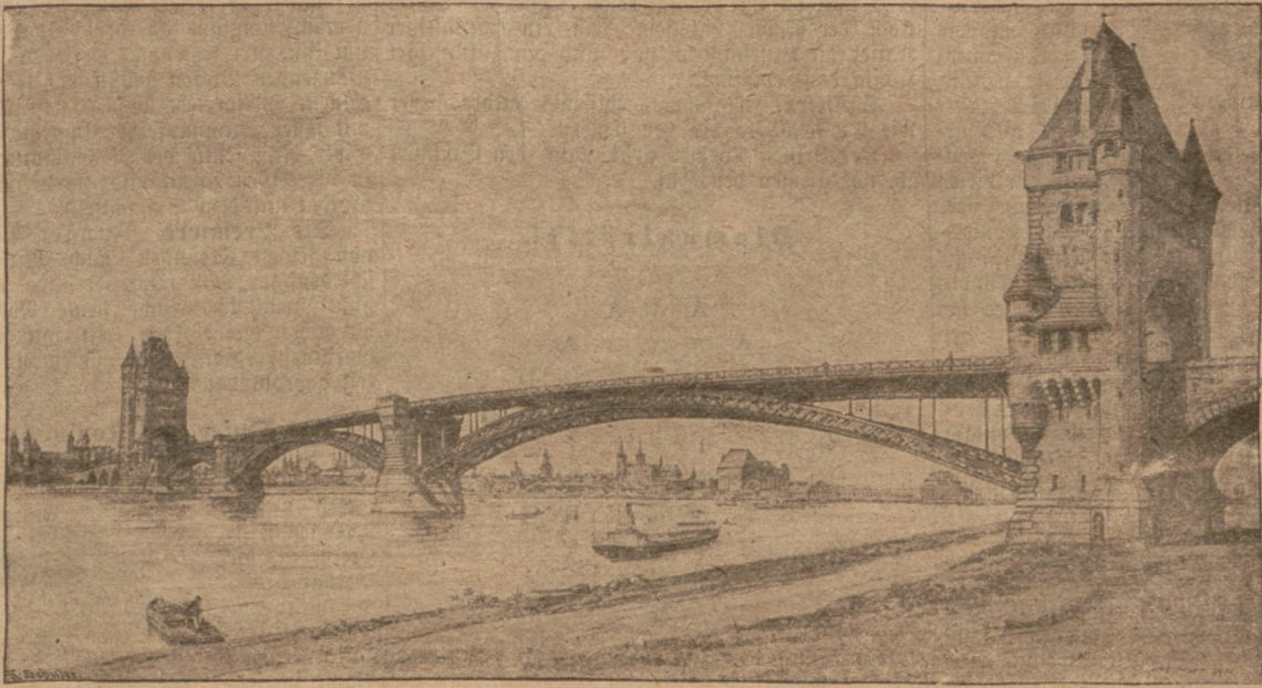
Die neue Straßenbrücke in Worms.
