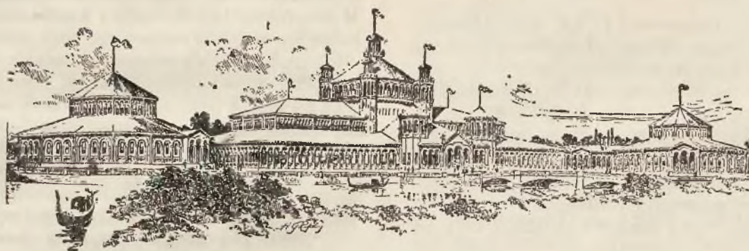
Gmach rybołówstwa ze zbiornikami przepływającej wody, z których jeden zawiera 27.000 galonów wody.
