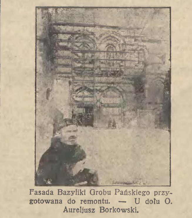
Fasada Bazyliki Grobu Pańskiego przygotowana do remontu. — U dołu O. Aureljusz Borkowski.
