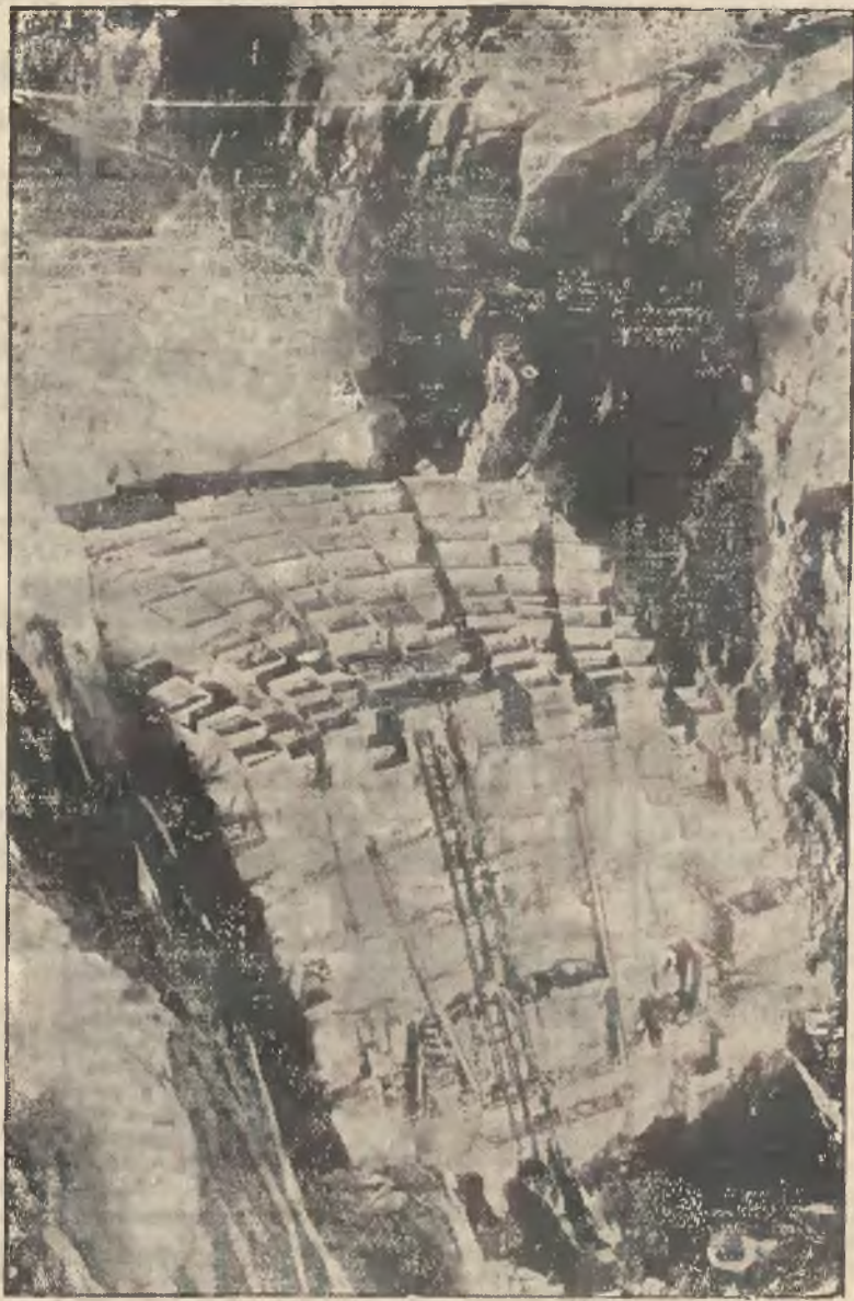
W amerykańskim Stanie Nevada pracuje obecnie kilka tysięcy robotników nad wzniesieniem grobli o rozmiarach wręcz fantastycznych. Wystarczy wspomnieć, że w konstrukcję stalową wpakowano już półtora miliona metrów kubicznych betonu, a wysokość grobli wynosi dopiero 90 metrów. Daje to pojęcie o rozmiarach budującej się grobli, która po ukończeniu będzie największą na świecie.
