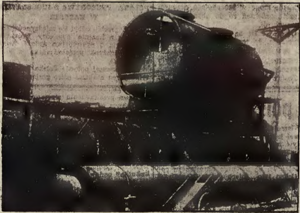
Instalacje, jakie widzimy na powyższym zdjęciu, zostały poczynione z polecenia uczonego francuskiego Jerzego Clau de'a na pokładzie statku „Tunis”. Mają one służyć celowi badania energii termicznej morza.
