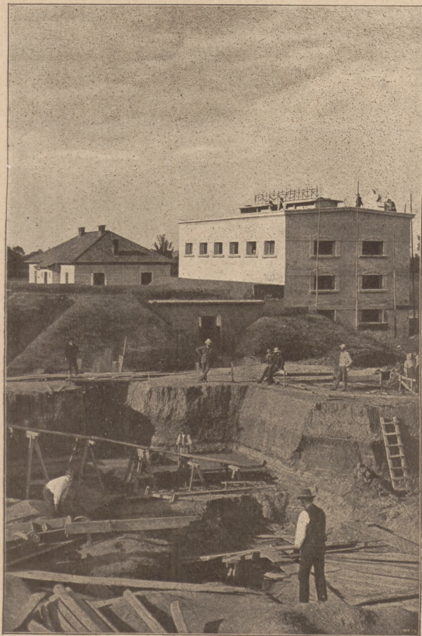
Roboty przy fundamentach pod halę pomp w Świerczkowie. (Obecnie budynek gotowy, a pompy są już w ruchu).
