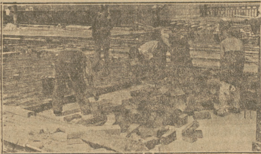
Robotnicy układają drewnianą kostkę nawierzchni.
