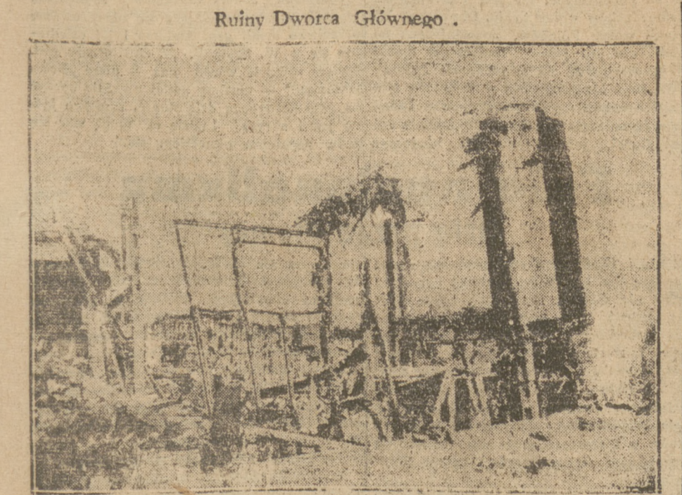
W ostatnich dniach SPB. rozpoczęło prace przy usuwaniu ruin, zburzonego Dworca Głównego.
