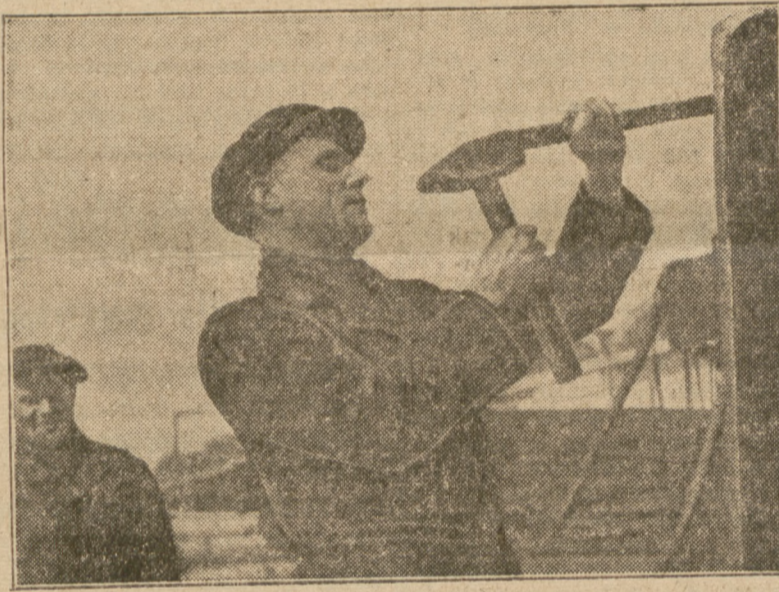
prace nad odbudową portu.
