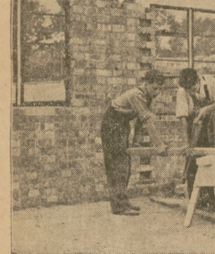
Uczniowie szkoły budowlanej w Ilford (Anglia) uczą się rzemiosła budując nowe osiedle robotnicze.
