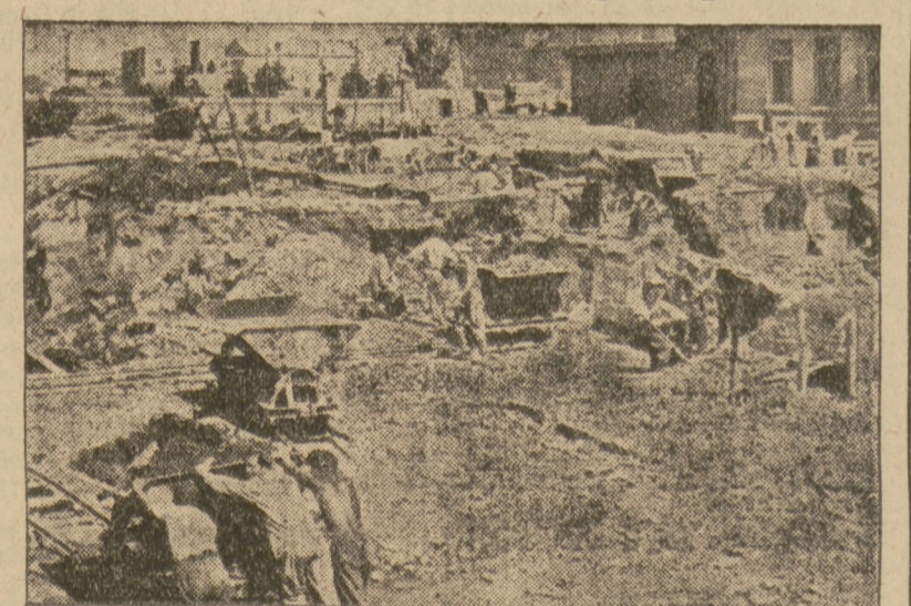
150 robotników przygotowuje wykop pod fundamenty drapacza Młn. Kontynuacja na rogu Boleja i Czerwinińskiego. (SAP)
