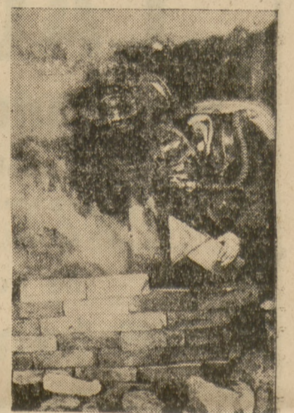
Budowanie tamy w czasie pożaru na kopalni (Fot. A. Bogusz CZPW).
