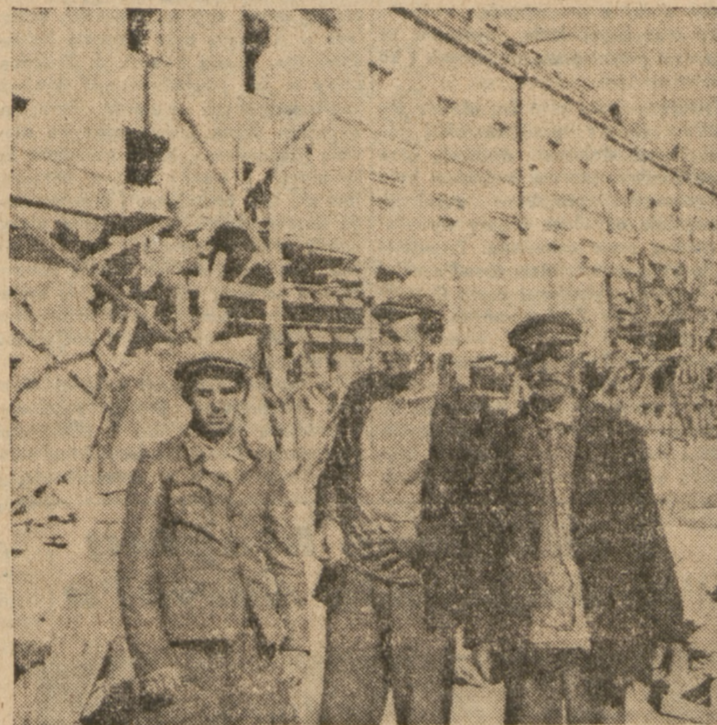
Przy budowie domków na Mariensztacie w Warszawie, gdzie znajdują mieszkania dawni lokatorzy zrozebranych na trasie W-Z. Trwa współzawodnictwo pracy. Na zdjęciu od lewej: trzech najlepszych murarzy: Janowski, Chojnowski i Telecki. (Foto SAP).
