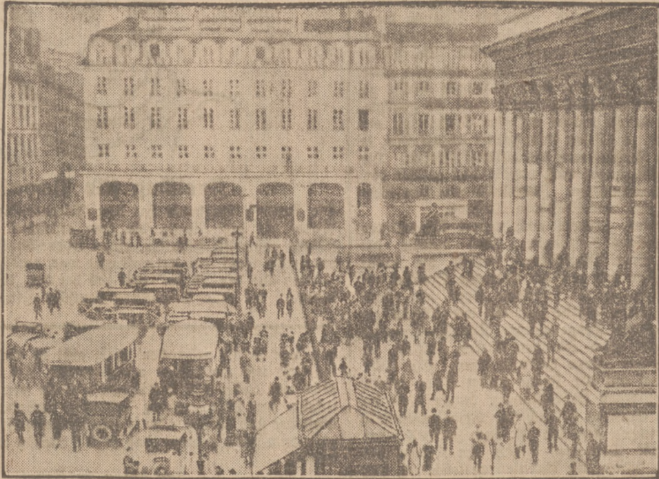
Zur Erleichterung des Verkehrs an der Pariser Börse, die zur Geschäftszeit von Scharen von Autos umlagert ist, hat der Polizeipräsident den Bau einer sechsstöckigen Garage unter dem Platz an der Börse genehmigt. Jedes Stockwerk des unterirdischen Baues erhält sechs zweigeschossige Fahrstühle, die die Autos von und zur Erdoberfläche befördern. Oben: Der Platz an der Pariser Börse. — Unten: Der Entwurf eines der Aufzüge.
