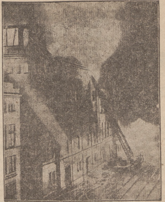
Ein Riesenseuer in Lübeck zerstörte in der Nacht zum 5. November ein vierstöckiges Speichergebäude. Ungeheure Werte an Kolonialwaren, besonders an Kaffee, wurden mit dem erst vor einem halben Jahr vollkommen neuausgebauten Speicher vernichtet.
