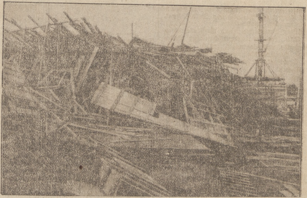
Ein Kirchenneubau eingestürzt
