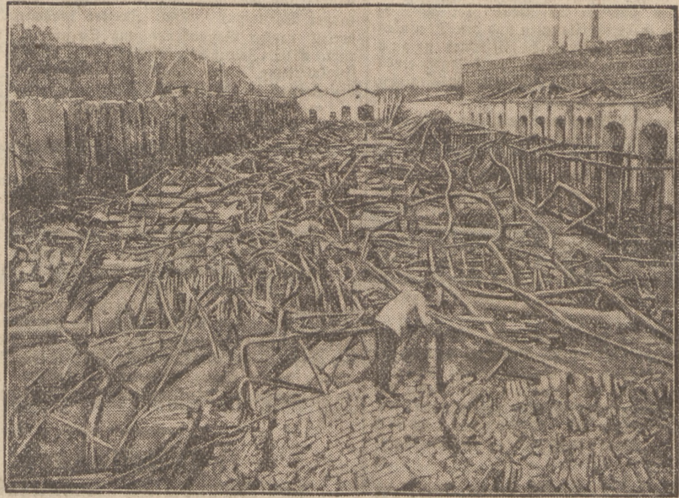
Die Brandstätte auf dem Güterbahnhof Hannover
