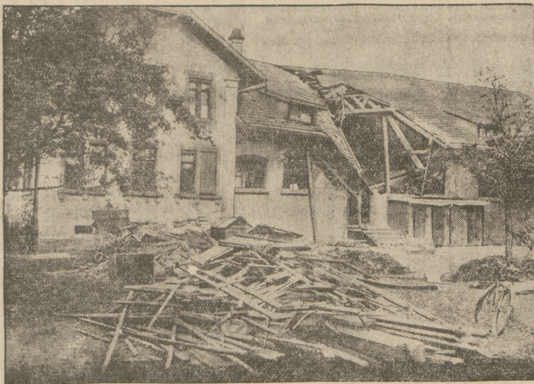
Das Einsturz-Unglück in St. Margrethen
