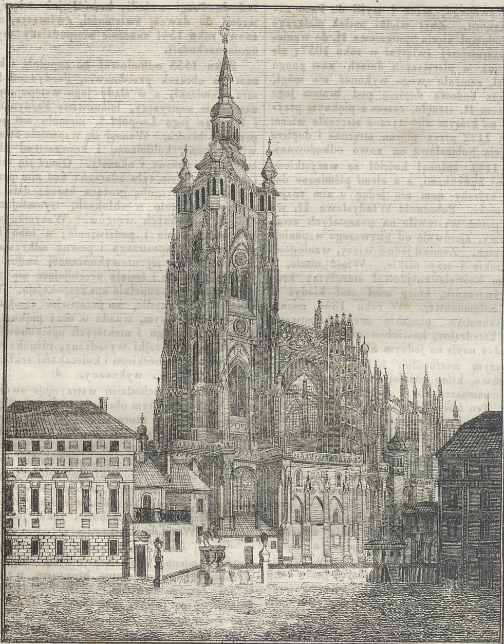
Widok tumu pragskiego ze strony południowej.
