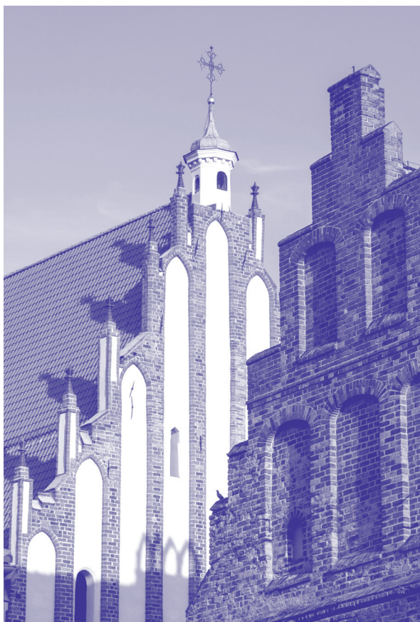
Fragment zachodniej elewacji kościoła Najświętszej Marii Panny, fot. J. Tritt, wł. CTK TRAKT
