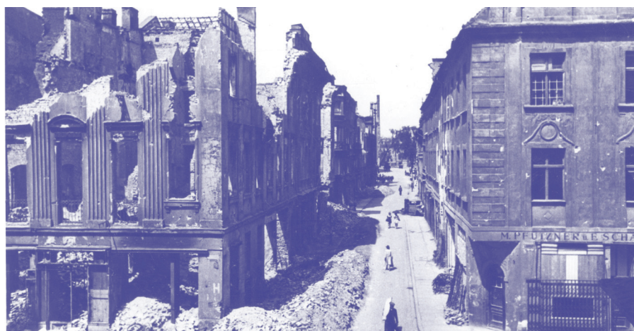
Zniszczenia wojenne, 1945, fot. i wł. Miejski Konserwator Zabytków w Poznaniu, źr. www.cyryl.poznan.pl
