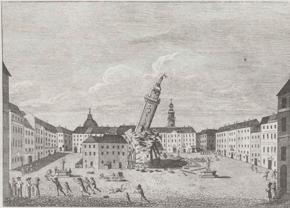
Der Einsturz des Rathhaus-Thurmes zu Lemberg den 14 ten July 1826.
