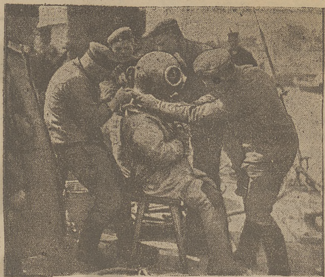
Na fotografii widzimy ubieranie murka, który za chwilę zejdzie na dno Dunaju, by oczyścić przystań w Ruszczuku i uprzyściupnić ją dla okrętów.
