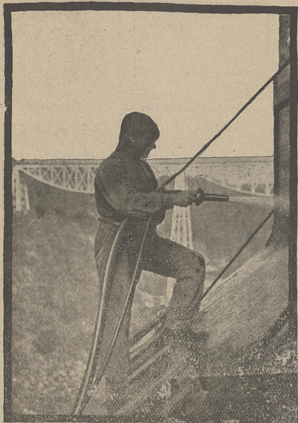
Natryskiwanie betonu sposobem „Torkret“
