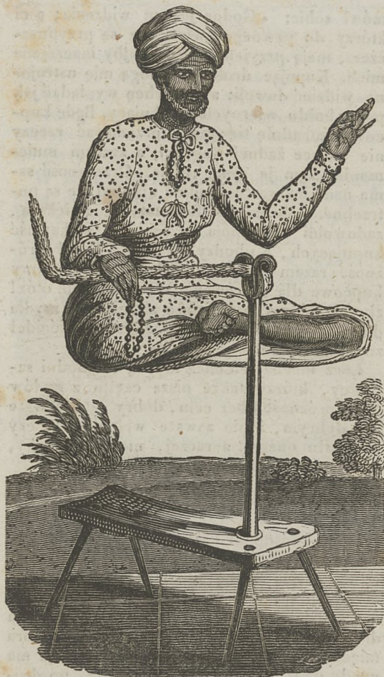
BRAMIN utrzymujący się na powietrzu bez żadnej widzialnej podpory.
