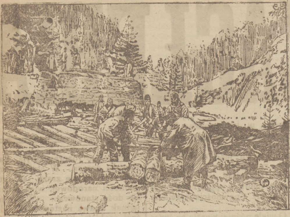
Naprawa toru kolejowego.
