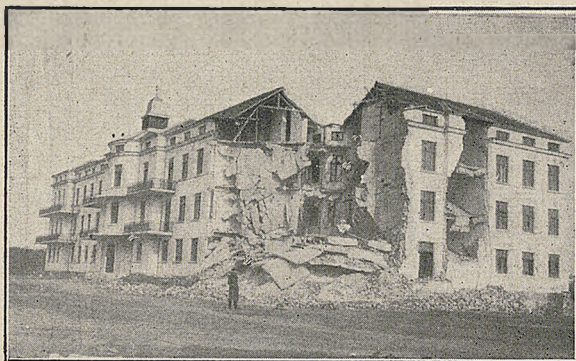
Zniszczony szpital przez trzęsienie ziemi w Filippopoli.
