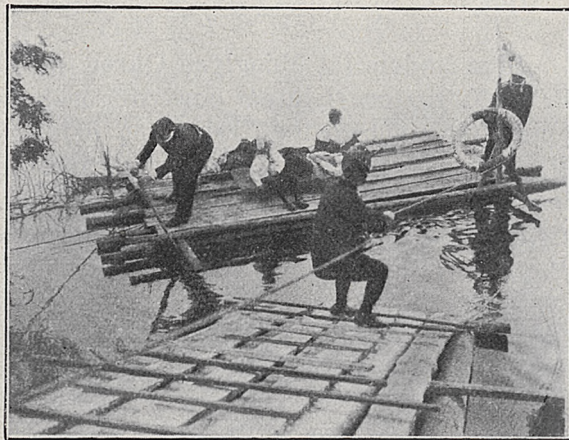
Ratowanie uszkodzonych zapomocą tratw w Siemianowicach.
