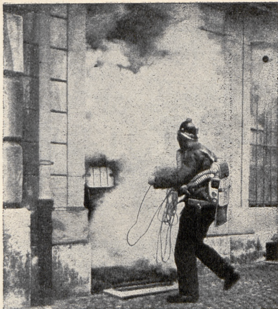
Dla ochrony przed tlenkiem węgla straż ogniowa pracuje często w apar. tlenowych izolujących.
