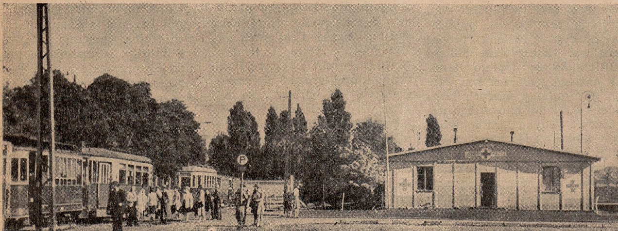
Punkt dworcowy PCK na stacji Łódź - Kaliska.
