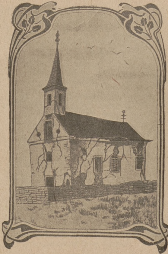
Kaplica w Zagrzebiu, stolicy Krocacji, po trzęsieniu ziemi.
