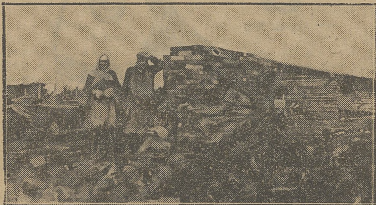
Robotnicy zatrudnione przy budowie.
