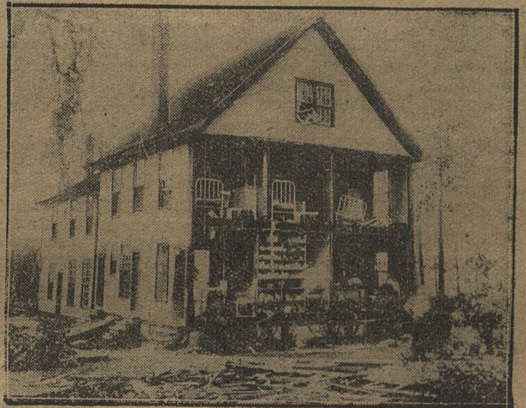
Miasto Dundee w stanie Illinois (U. S. A.) nawiedzone było potężnym huraganem, który spowodował wielką ilość ofiar w ludziach. Na zdjęciu — dom z „odciętą” wiatrem ścianą.
