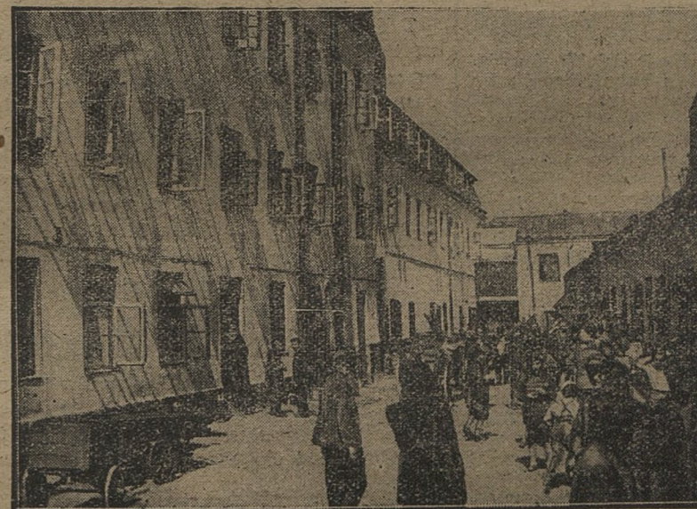
„Przejście dla złodziei”. Dom przechodni z hal na Krochmalną 8.
