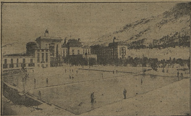
Stizgawka hotelowa przy „Palace-Hotel“ w Majolu (Austria)
