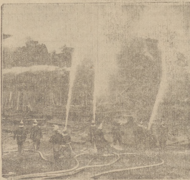
W zakładach przemysłowych Standard Ammonia w Londynie nastąpił olbrzymi wybuch i pożar fabryki.
