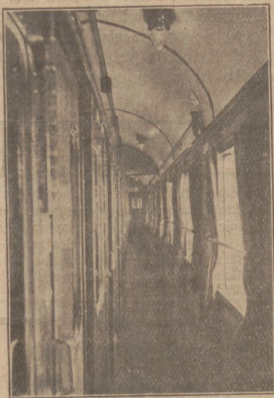
Rys. 2. Oświetlenie elektryczne wnętrza wagonu osobow. budowy fabryki H. Cegielski w Poznaniu.
