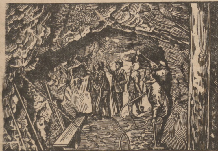
Bohrarbeiten im Tunnel.
