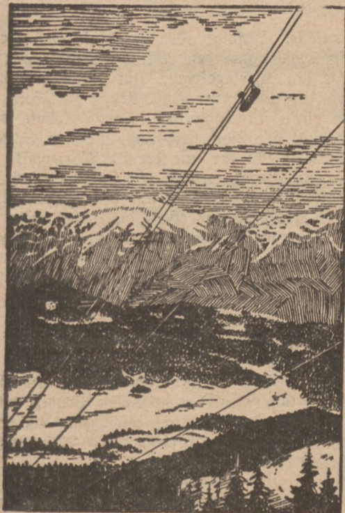
Hilfsseilbahnen befördern das Material.
