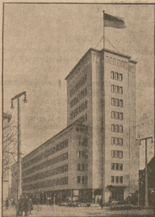
Die „Grenzwacht“, ein Großhausblock nach den jüngsten Errungenschaften der Technik als Stahlhaus erbaut, wurde dieser Tage in Aachen eingeweiht. Dieses Großhaus ist eine kleine Stadt für sich: Von den Dienststellen der städtischen Behörden bis zum Lichtspieltheater findet sich hier alles vor.
