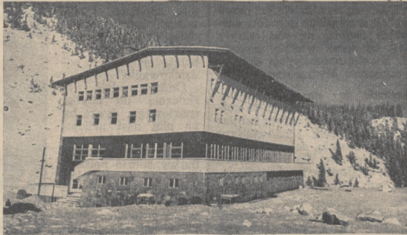
Nowoczesny gmach Hotelu Turystycznego na Kalatówkach.
