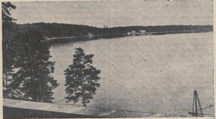
— port „Hotelu nad Jeziorami” w budowie. Dziś — już gotów
