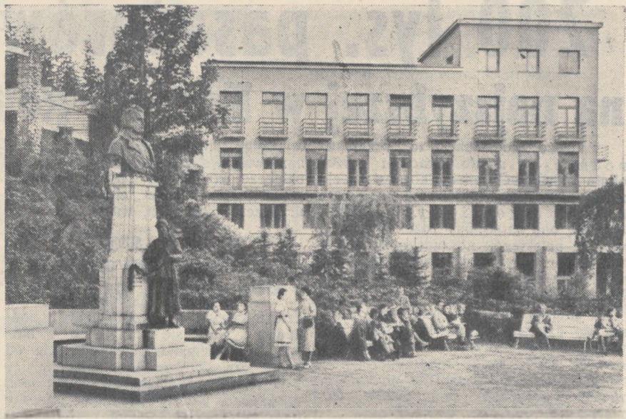
Fragment deptaka z pomnikiem Mickiewicza i bocznym skrzydłem nowo-wzniesionego „Hotelu Zdrojowego”.
