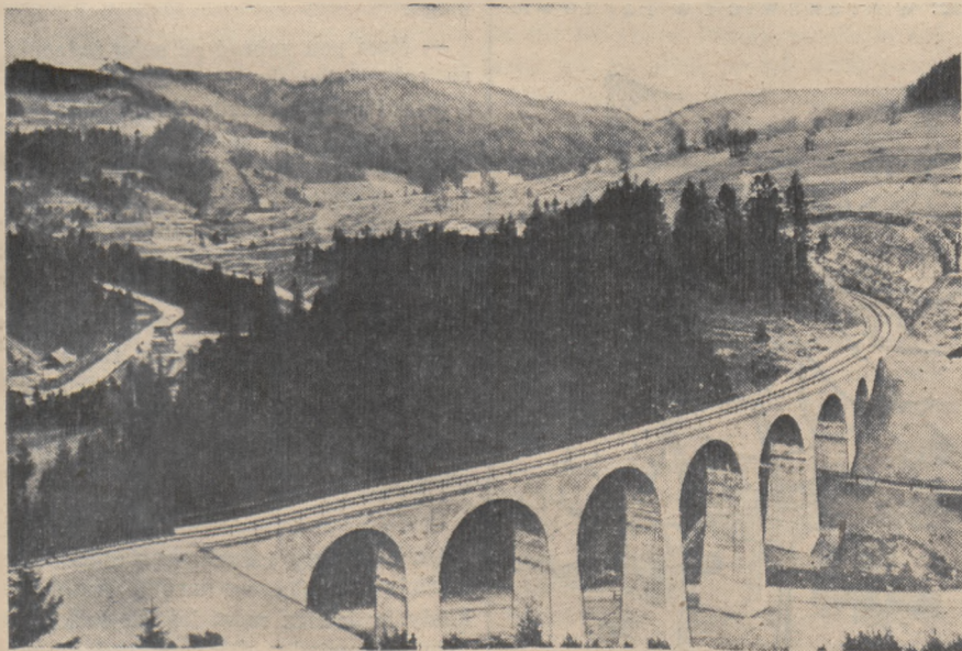
Wiadukt kolejowy w Głębcach (Beskidy śląskie)
