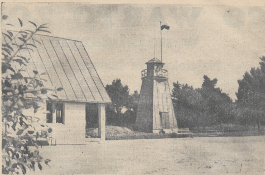
Wieża ciśnień w roli latarni morskiej.
