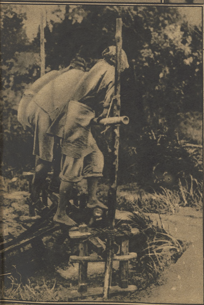
PRYMITYWNA „MASZYNA MELIORACYJNA” Znaczną przepuszczalność gleby w Honan umożliwia łatwe nawadnianie terenu. Słusze się wobec takiego stanu rzeczy łopatkowe koła poruszane pracą nóg, znamiennie spełniających rolę molo-pomp i kompresorów wodnych.
