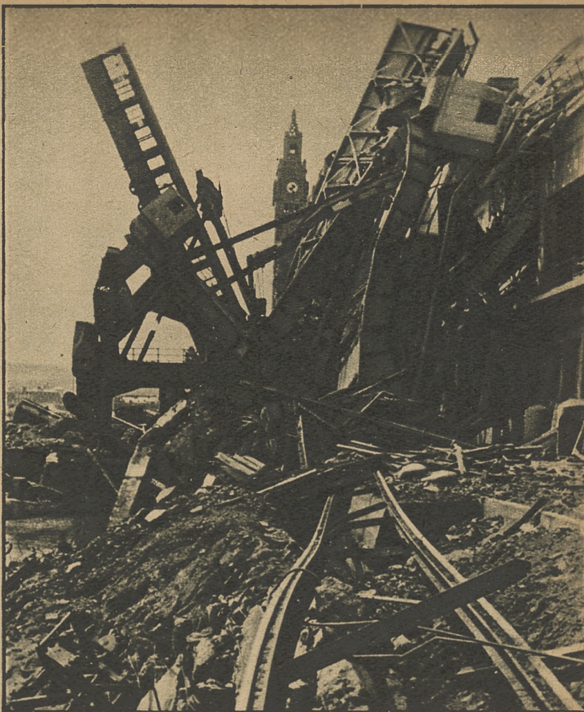
Powyżej: Taki obraz przedstawiają dziś urządzenia portowe miasta Cherbourg. Są one tak zniszczone, że lądowanie w tym miejscu wojsk brytyjsko-amerykańskich jest uniemożliwione.
